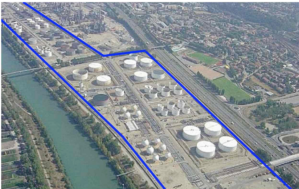
FIG. 2.1 – Une partie du parc des stockages de la raffinerie de Feyzin
